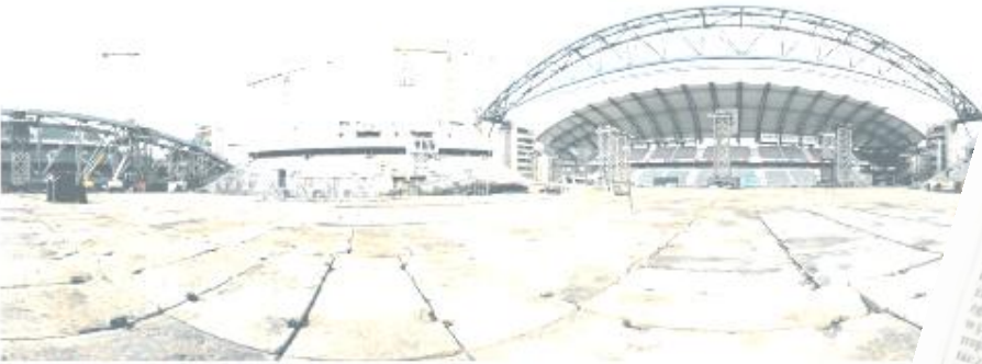
Stadion Lecha jest gruntownie przebudowywany z myślą o Euro
